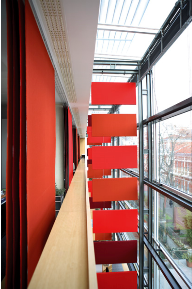
Institut Pasteur, Vorhangfassade, Paris
