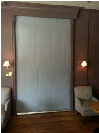
Textil-Flexibler-Feuerschutzabschluss EW90 Referenzobjekt: Monbijouplatz 1, Berlin
