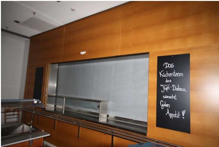
Textil-Flexibler-Feuerschutzabschluss in erhöhter Einbaulage Referenzobjekt: Jugendgästehaus Dachau
