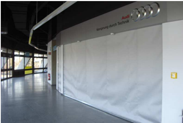
Textil-Flexible-Rauchschürze mit seitlichen Führungsschienen Referenzobjekt: AUDI Dome, München
