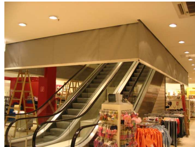
Textil-Flexible-Rauchschürze o. seitliche Führungsschienen Referenzobjekt: C& A, Graz (Österreich)
