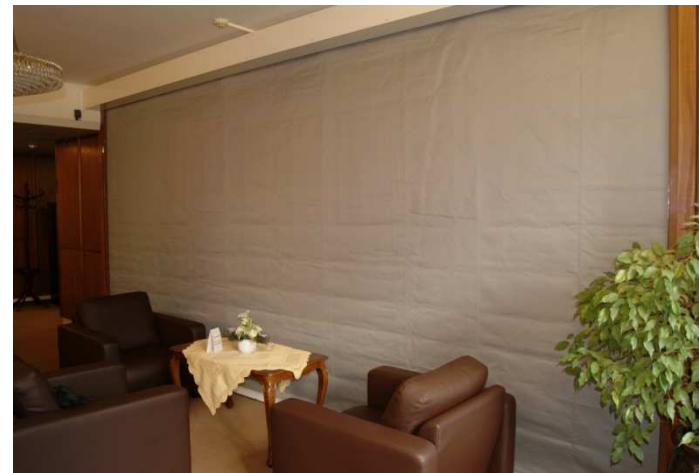
Textil-Flexibler-Feuerschutzabschluss E90 Referenzobjekt: Hotel Graz (Österreich)
