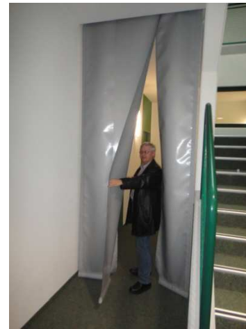
Textil-Passierbare-Rauchschürze (Streifenausführung) Referenzobjekt: Hans-Leipelt-Schule, Donauwörth
