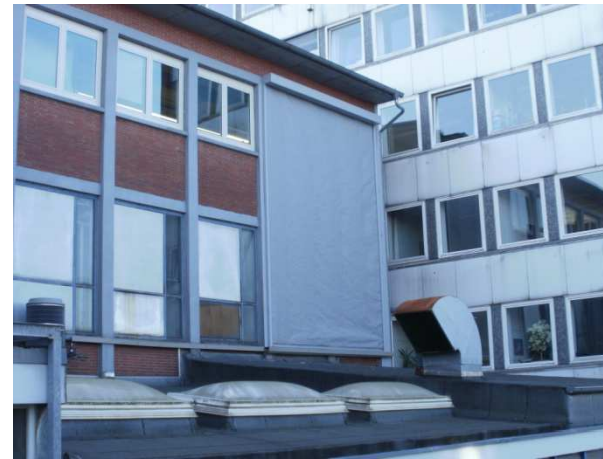
Textil-Flexibler-Feuerschutzabschluss Einsatz im Außenbereich Referenzobjekt: Mohn Media, Gütersloh
