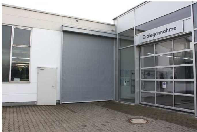
Textil-Flexibler-Feuerschutzabschluss Einsatz im Außenbereich Referenzobjekt: VW /AUDI Berner, Wolfratshausen
