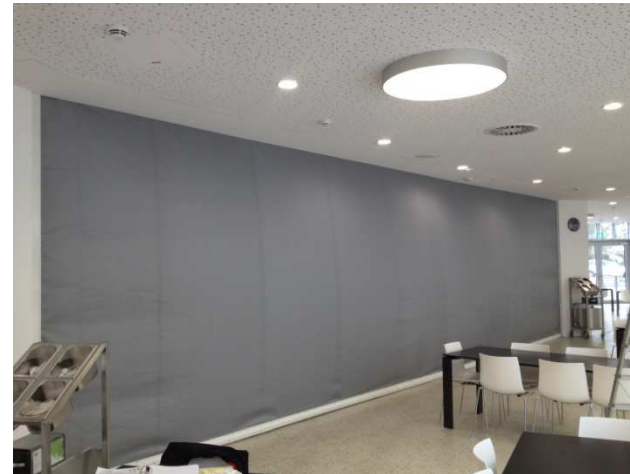
Textil-Flexibler-Rauchschutzabschluss Referenzobjekt: Albert Einstein Gymnasium, Bochum
