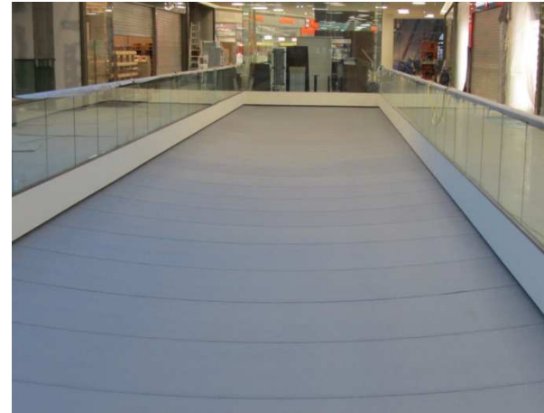
Textil-Flexibler-Feuerschutzabschluss in horizontaler Einbaulage Referenzobjekt: Stadtgalerie Schwaz (Österreich)
