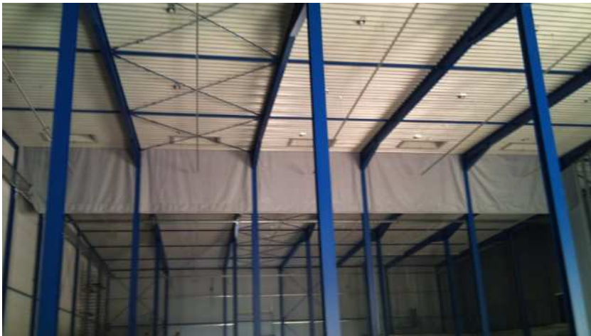
Textil-Starre-Rauchschürze Referenzobjekt: BIONORICA SE, Neumarkt i.d. Oberpfalz
