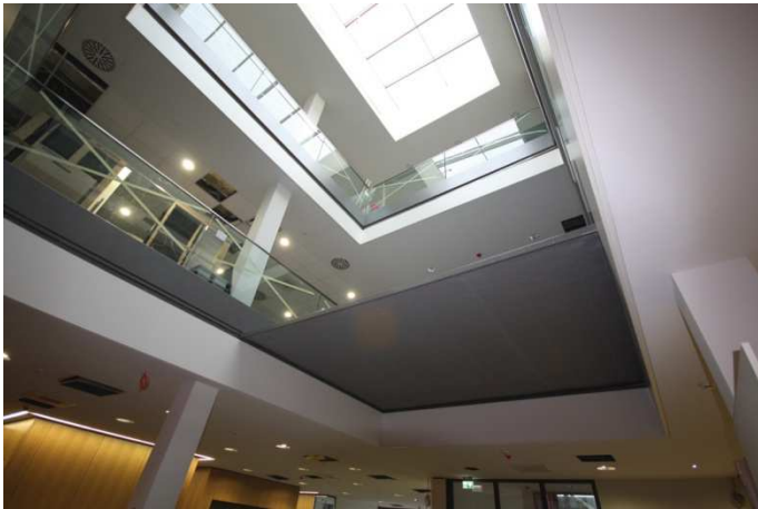
Textil-Flexibler-Feuerschutzabschluss in horizontaler Einbaulage Referenzobjekt: Sparkasse Herborn
