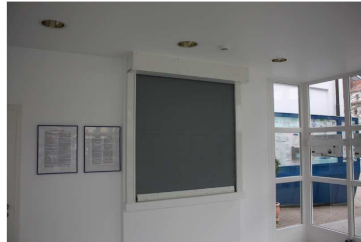
Textil-Flexibler-Feuerschutzabschluss EW90 mit Rauchschutzfunktion in erhöhter Einbaulage Referenzobjekt: Dr. Stammberger Halle, Kulmbach
